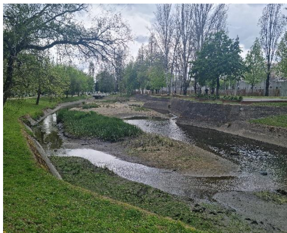
Εικ. 9 & 10 Ποταμός «Este», λιμνοθάλασσα πριν και μετά την αντικατάσταση των κατασκευών από σκυρόδεμα με λύσεις μηχανικής βασισμένες στη φύση
