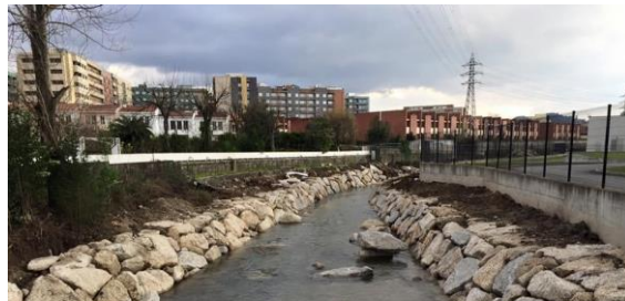
Εικ. 9 & 10 Ποταμός «Este», λιμνοθάλασσα πριν και μετά την αντικατάσταση των κατασκευών από σκυρόδεμα με λύσεις μηχανικής βασισμένες στη φύση
